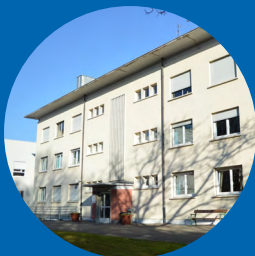
Institut de Formation - Colmar 18 rue Charles Sandherr 68000 Colmar
