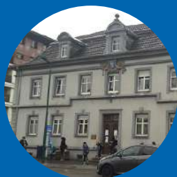
Institut de Formation - Altkirch Quartier Plessier, Bâtiment 23 - Avenue du 8e Régiment de Hussards 68130 Altkirch
